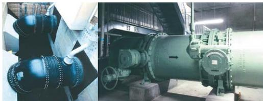
遠山で生産されたダクタイル鑄鉄管が使われている(φ1350mm~2500mm)
