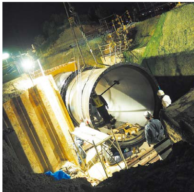
今回の工事の風景。この直管に接続するよ。
