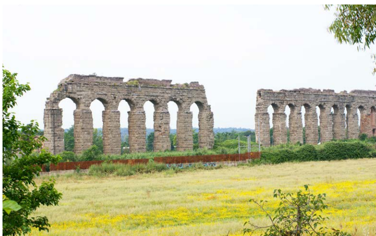
現水道橋公園(Parco degli Acquedotti)にある水道橋の遺跡。高さ約30mの位置を水道が走る。立派な橋脚の上に新アニオ水道とクラウドシア水道の2本の水道が通っている。
