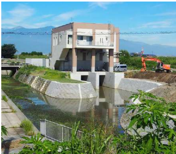
川上(右図①)からの眺め。左側の流れは川下へ。右側の流れは取水口から2台のポンプに接続。令和4年度稼働開始予定で現在土木工事中。
