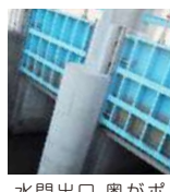
水門出口。奥がポンプからの出口。(上図③)。
