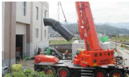
場外のポンプ場と吐出水槽(クレーン背後)を繋ぐ管の2020年11月の搬入風景。(山梨県様ご提供写真)
