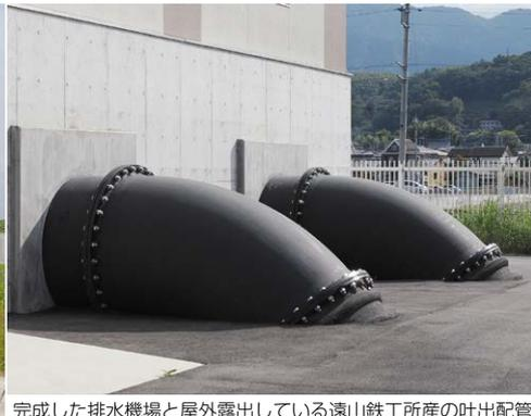
完成した排水機場と屋外露出している遠山鉄工所産の吐出配管。
