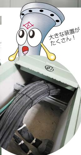
ポンプを動かす原動機の左上に見えるのは、燃料の重油が入った槽。地震などで燃料油が溢れてしまっても漏電しないように、配線ピット内のケーブルは支持金具で地面から浮いた状態になっている。
