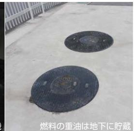
排水機場が稼働するのは災害など非常時が想定されるため、平時から自家発電で全てを賄うように設計されているよ(いつでも対応できるように!)。地下に貯蔵されている重油を燃料とした発電機は72時間稼働できる設計(国の定める揚排水ポンプ設備技術基準では48時間以上なので、かなり高スペックな設計!)
